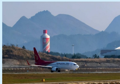
贵州遵义茅台机场工程
