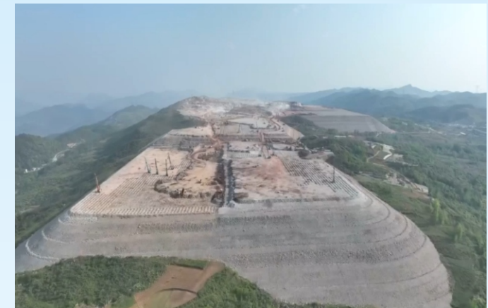
施工中的贵州黔北（德江）民用机场工程
